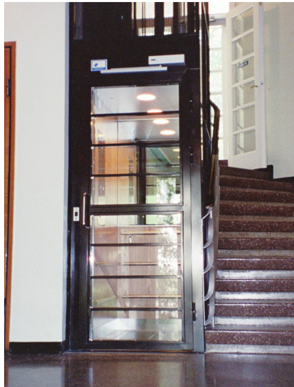
Porrashuone hissi asennettuna.
