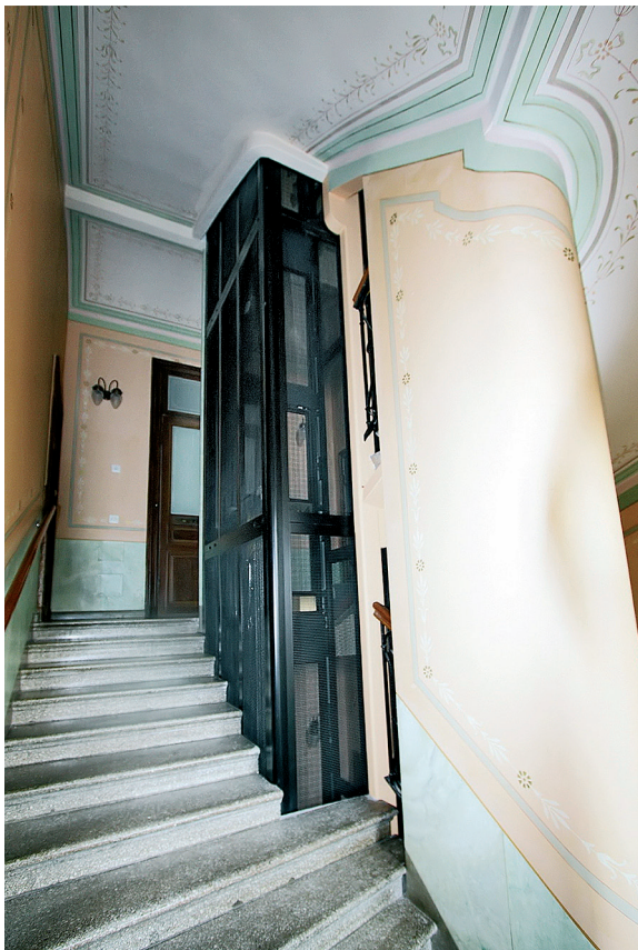
Hissikuilu lepotasolta katsottuna.
