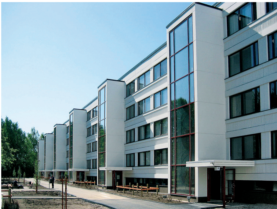
Julkisivu uusilla porrastorneilla.
