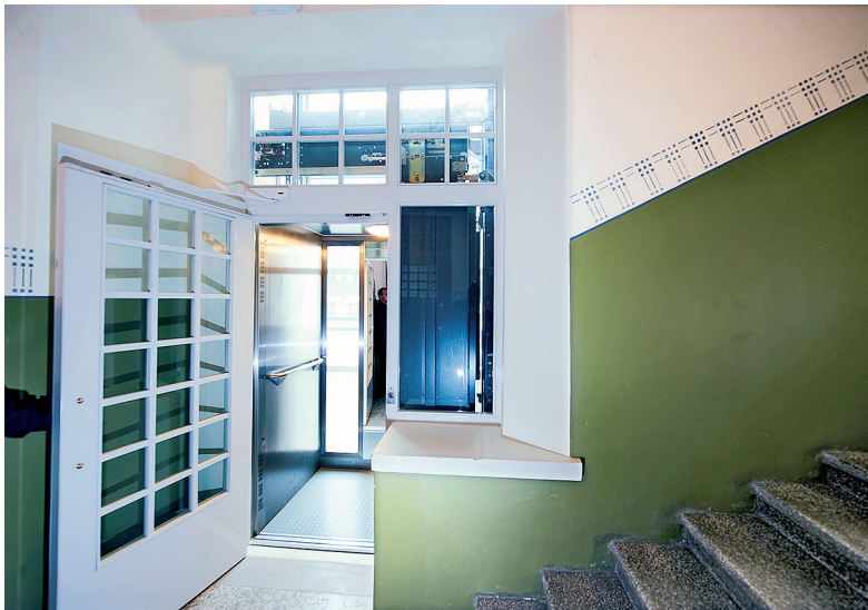
D-portaassa pihanpuolen sisäänkäynti uusittiin. Hissi asennettiin vanhan sisäänkäynnin kohdalle tuuletusparvekkeiden linjaan.
