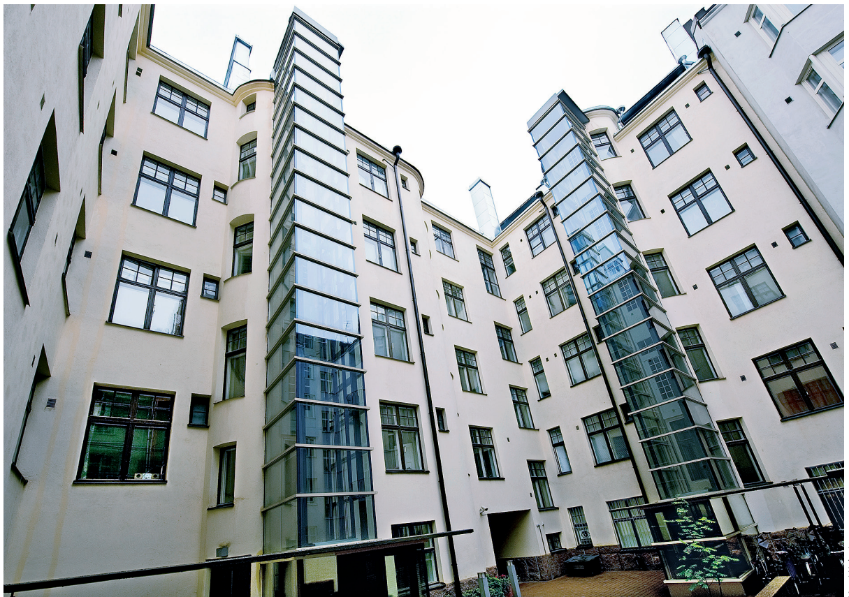
Kuva pihalta. A- ja C-portaiden lasiverhoillut hissikiuilut.
