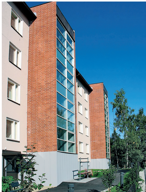
Uudet hissitornit julkisivussa.
