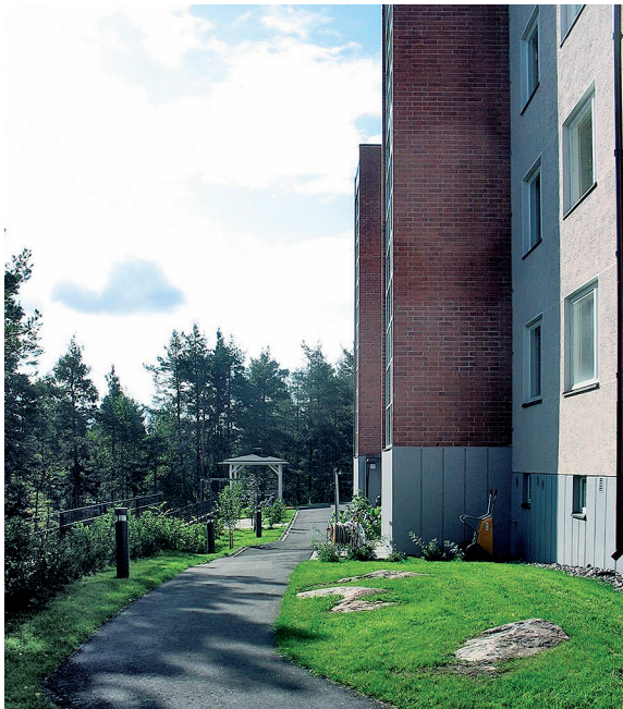
Talon julkisivussa uudet hissitornit.
